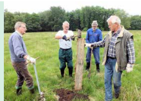
Start zum Zaunbau auf der Lungenenzianfläche: Ein abschließender Schlag und der erste Eckpfahl steht. Jetzt noch verfüllen und Feststampfen (von links: Reinhard Kempe, Fritz Visarius, Günther Neubauer, Peter Roocks)
