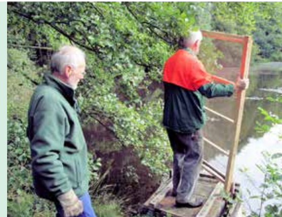
Die Anbringung des Gitterrahmens am großen Mönch/Dittmer-Teiche: Sicherheit für die Kleinfische bei gelegentlicher Senkung des Wasserstandes im Teich (von links: Hinnerk Lehmann, Günther Knabe)
