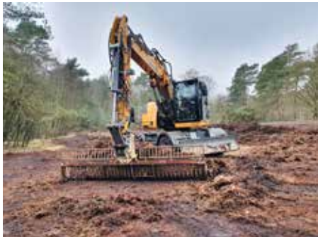
Abtrag des Oberbodens nach der Kiefernrodung Anfang März 2023. Der Sand wirkt zunächst noch braun-schwarz, bedingt durch kleine organische Partikel. Diese waschen sich mit Regenfällen aus, bis der weiße Sand sichtbar wird.
